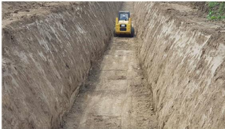
Подравняване на дъното на траншеята
